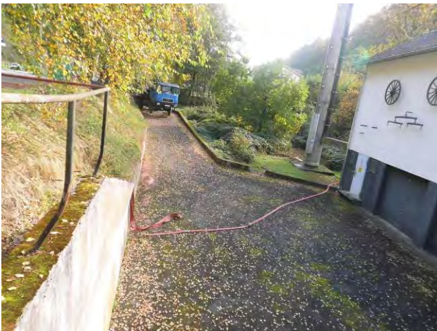
Bild 3: Ausführung BK 3, Blick nach Südosten
