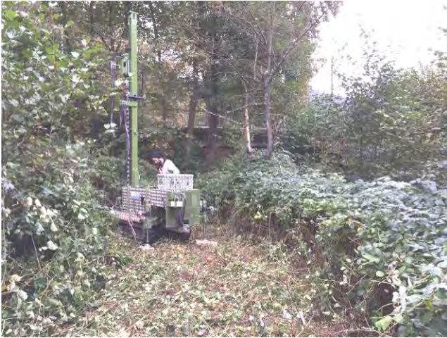
Bild 7: Trockendrehbohrung zur Kampfmittelfreimessung bei BK / DPH 4, Blick nach Süden
