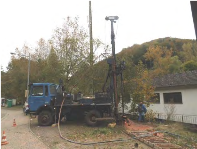
Bild 1: Ausführung BK 1, Blick nach Südosten
