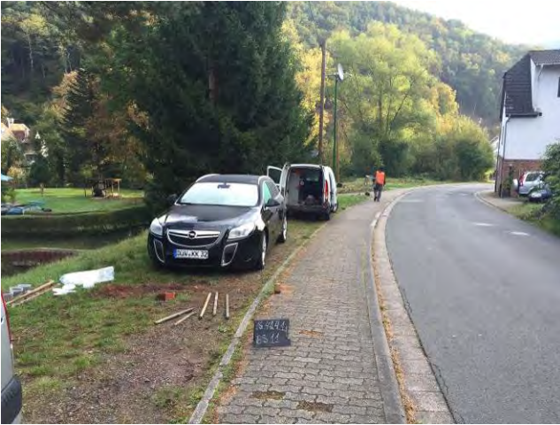
Bild 25: Ausführung BS 11, Blick nach Osten
