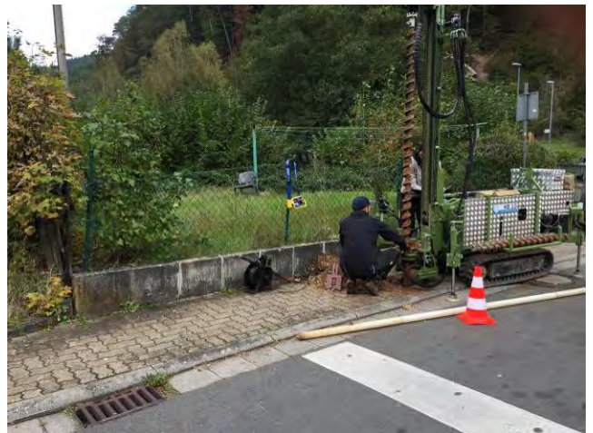
Bild 10: Trockendrehbohrung zur Kampfmittelfreimessung bei BK / DPH 5, Blick nach Nordwesten
