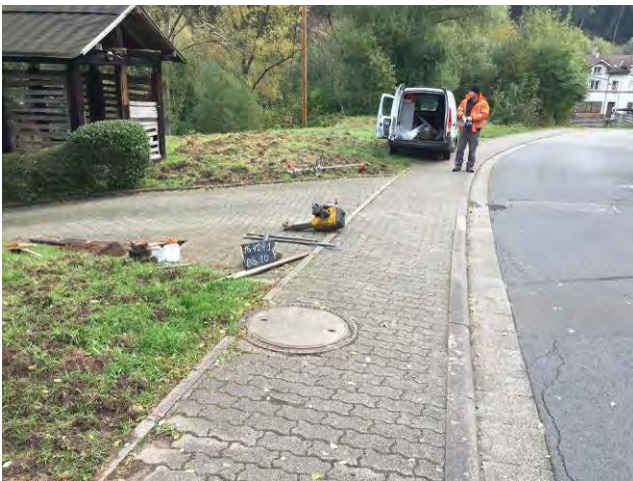
Bild 21: Ausführung BS 10, Blick nach Osten
