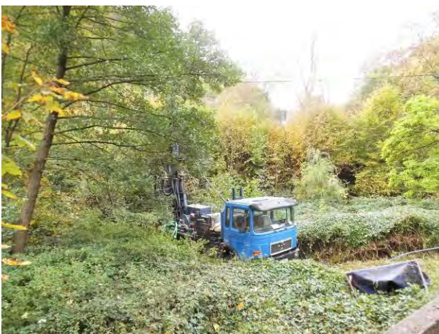
Bild 5: Ausführung BK 4, Blick nach Westen
