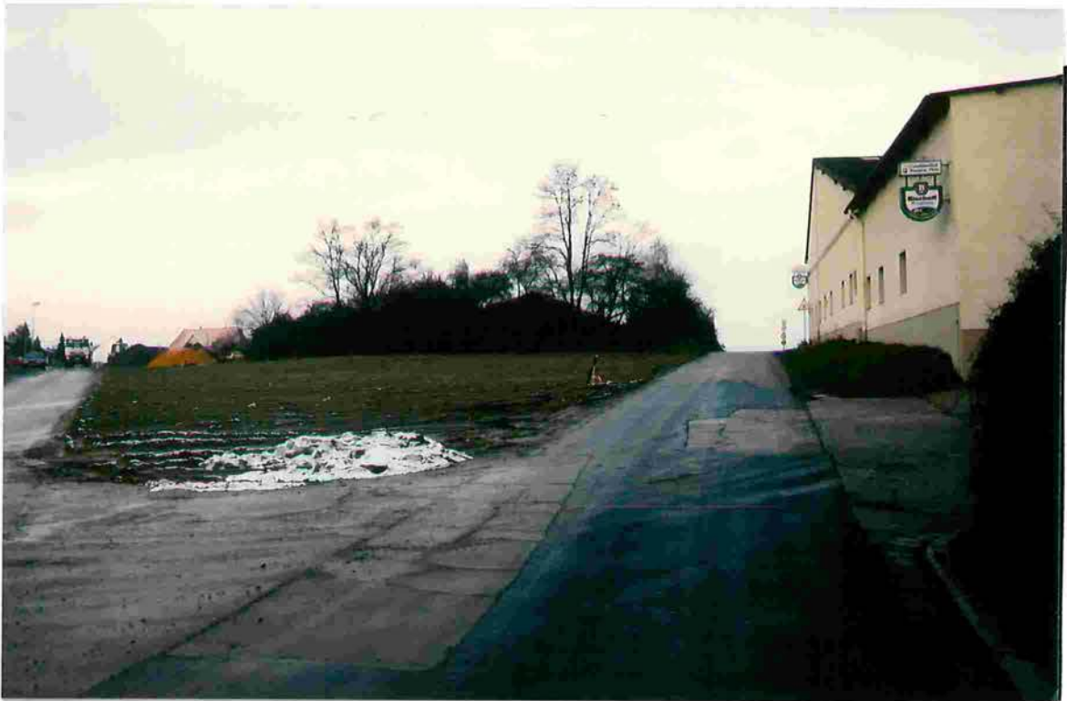
Foto 1: Blick aus Südosten vom Kreuzungsbereich des Mühlweges mit der Speyerer Straße (alte Führung) auf das Plangebiet der 3. Änderung. Rechts ist der bestehende landwirtschaftliche Betrieb mit angeschlossener Gastronomie zu erkennen.
