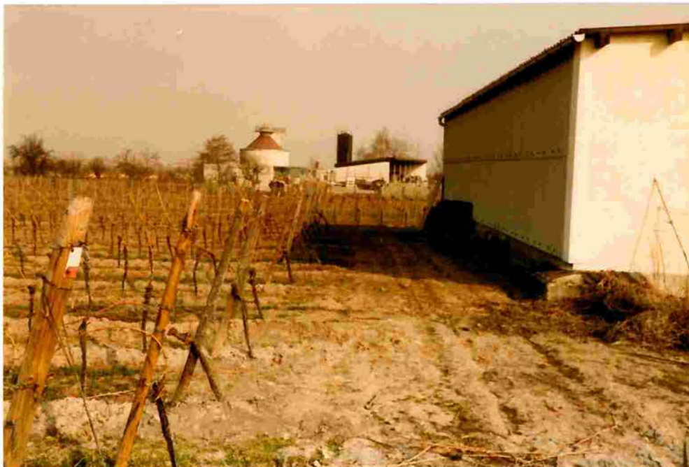
Blick von Westen nach Osten an der Nordseite des Aussiedler-Wirtschaftsgebäudes vorbei auf die Kläranlage. Hier ist eine Eingrünung gemäß dem 3 m - Pflanzschema zur Kaschierung der Baukörper erforderlich. Ebenso ist der rückwertige Bauhof durch eine verbindliche, gestaffelte 3 m - Pflanzung landschaftsgerecht einzugrünen.
