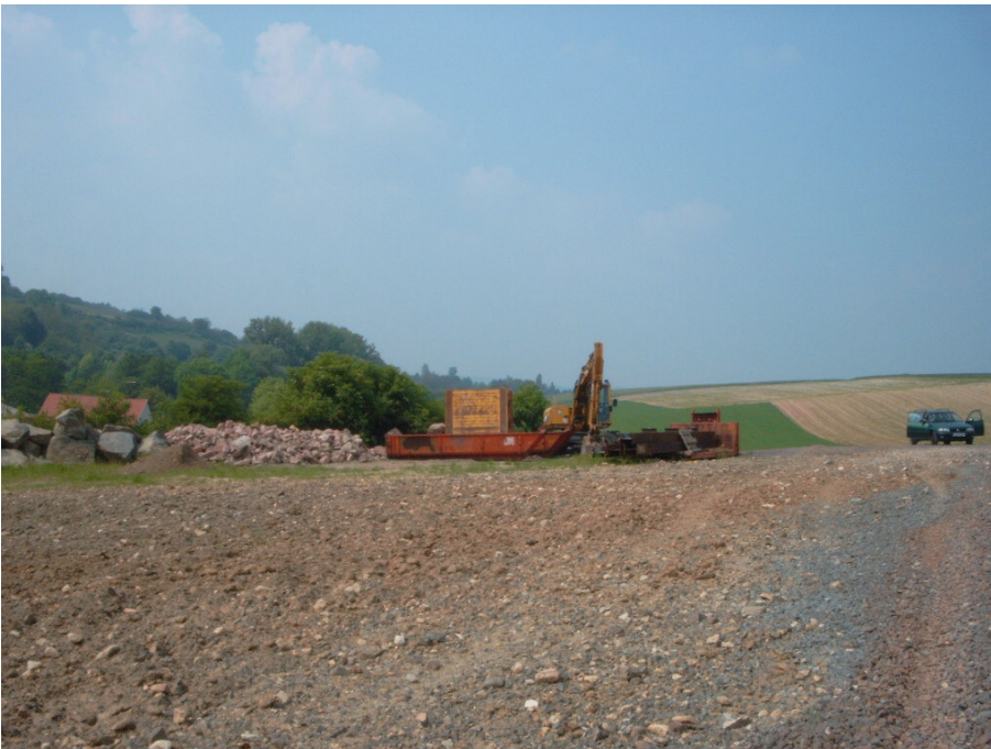
Bild 2: von Ost nach West auf Fläche mit Rohboden und Schotterweg, im Hintergrund Arbeitsgerät und Mulden sowie Steinlager
