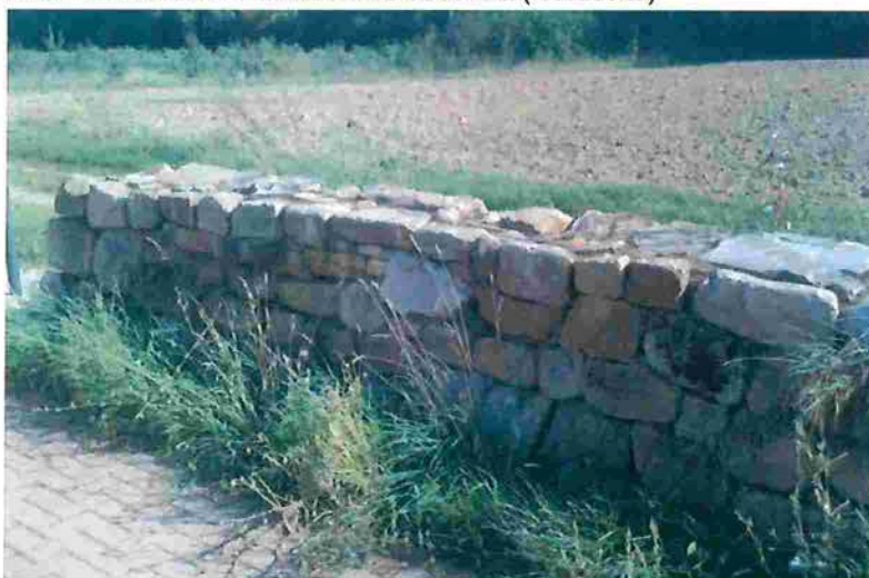
Abb. 4: westlicher Trockenmauerabschnitt (Nordseite)
