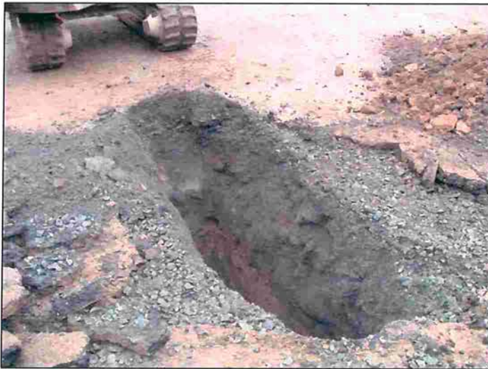
Abbildung 3: Schwarzdecke mit zugehöriger Tragschicht (Schotter)
