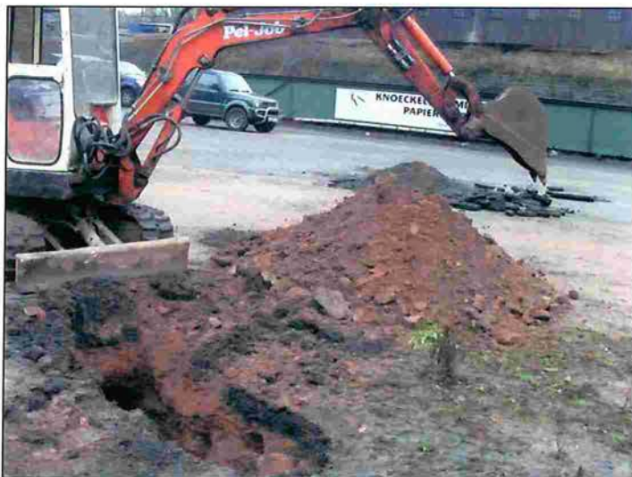
Abbildung 3: Schwarzdecke mit zugehöriger Tragschicht (Schotter)
