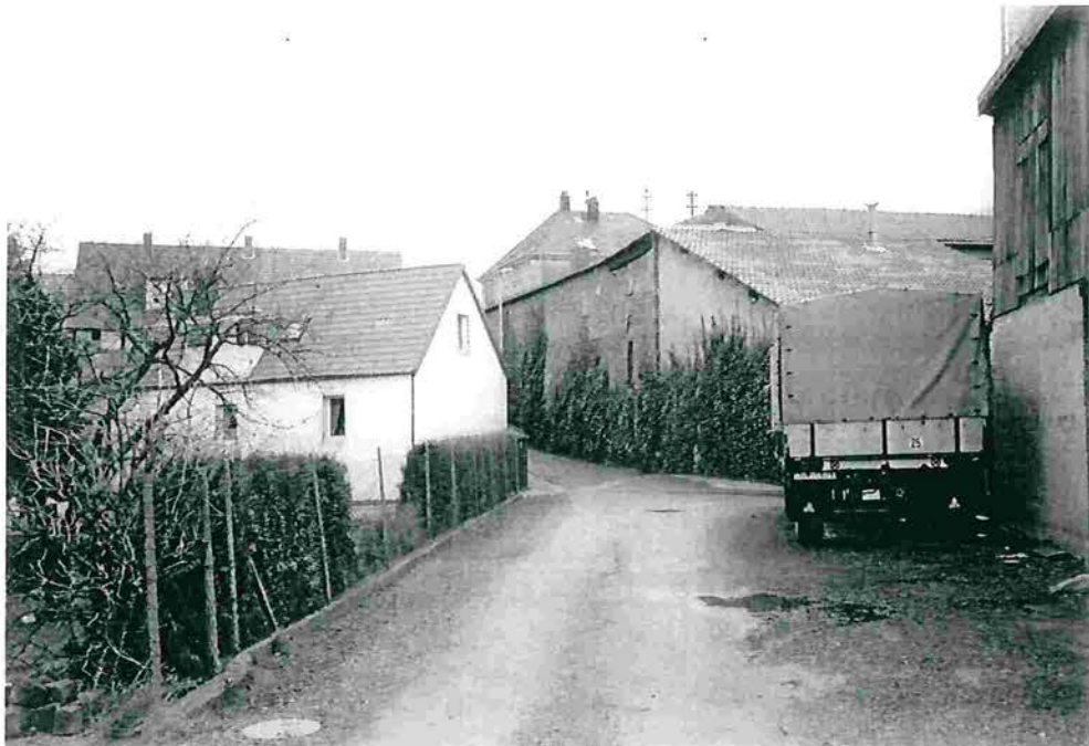
Bild: 1 Blick von der Straße „Staufer Weg“. Die am rechten (südlichen) Bildrand stehenden landwirtschaftlichen Betriebsgebäude sollen im Zuge der Überplanung des Geländes abgerissen werden.
