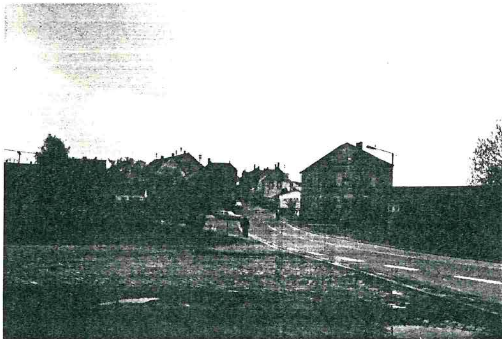
4 DIE UNGEORDNETE PLATZANLAGE VON NORDEN NACH SÜDEN MIT DER B 47 (BAHNHOFSTRASSE). LINKS TREFFEN POST- UND FABRIKSTRASSE AUF. GRÜNRABATTEN IN FREIZUHALTENDEN SICHTWINKELN WERDEN KÜNFTIG EINE VORHER AUF DIE FABRIKSTRASSE EINLAUFENDE POSTSTRASSE AUFNEHMEN. AUCH DIE PLATZFLÄCHE IM VORDERGRUND ERHÄLT GRÜN- BINDUNG!
