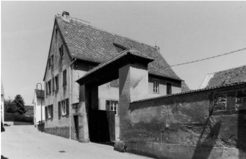
Abbildung 3: Nachbargebäude mit Toranlage und verputzter Sandsteinwand
