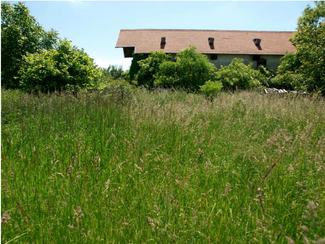
Bild 13: Das sanierte Wirtschaftsgebäude des Landwirtschaftshofes bietet kaum Quartiere für Fledermäuse oder Gebäudebrüter unter den Vögeln
