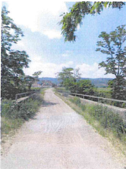
Abbildung 11: Buschweg im Osten (Blick von Osten)
