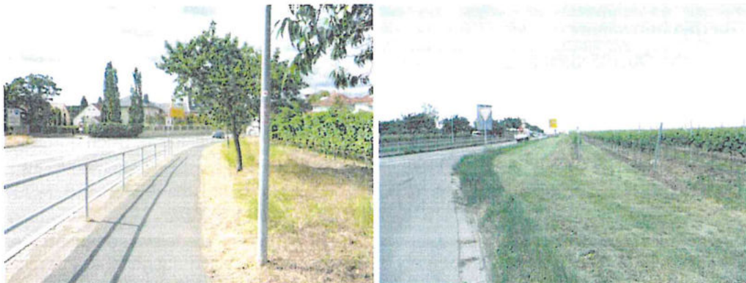
Abbildung 6: Blick von Norden entlang der Westseite der Landesstraße (Radweg und Allee, links) und von Süden entlang der Ostseite (Saum, rechts)
